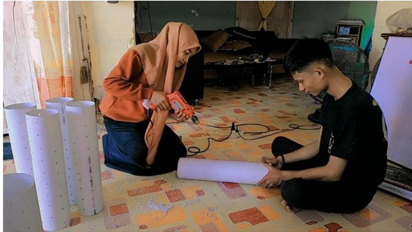
**Gambar 3.** Pembuatan Pipa Biopori
